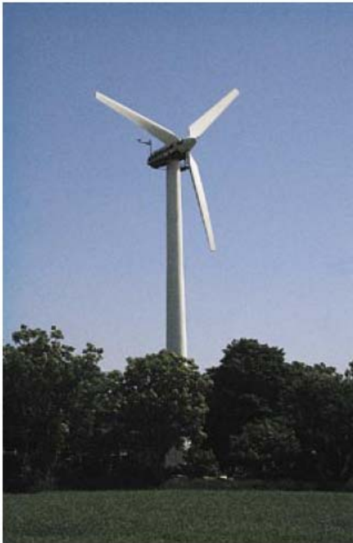
Vindmølle på 55 kW og med 30 m tårnhøyde ved Jæren Folkehøgskole Foto: Haavard osthagen, NVE
